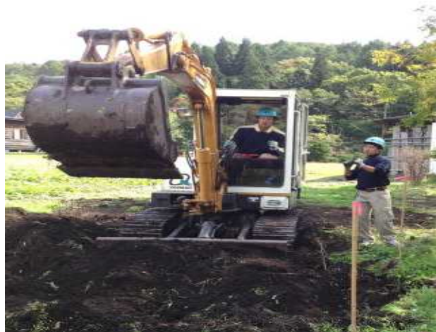
バックホーの操縦訓練（どちらも緊張します）
